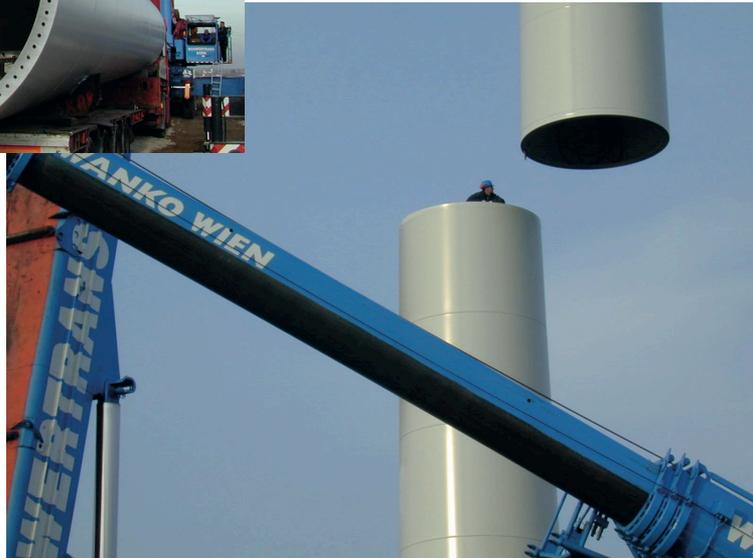
Der Turm kann über 140 m hoch sein und besteht meist aus Stahl oder Beton.
