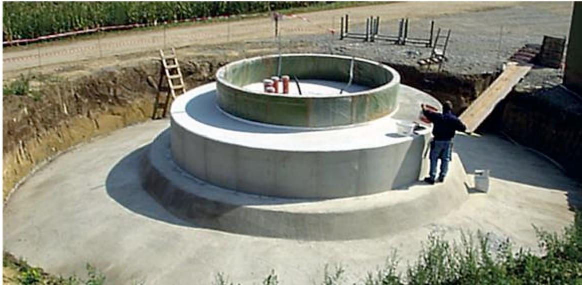
Um das Windrad errichten zu können, braucht man ein Fundament. Schließlich ist so eine Anlage gleich über 1.000 Tonnen schwer. Dennoch ist es nur rund 20 Meter breit und ein paar Meter tief.
