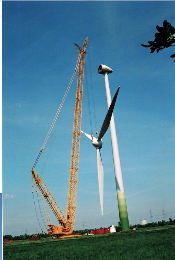
Der letzte Schritt ist die Rotormontage. Ein Flügel einer modernen Anlage ist über 50 m lang und wiegt mehr als 10 Tonnen.
