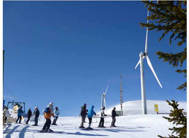
Abbildung 29: Windpark Skigebiet Salzstiegl, Friedl Kaltenegger
